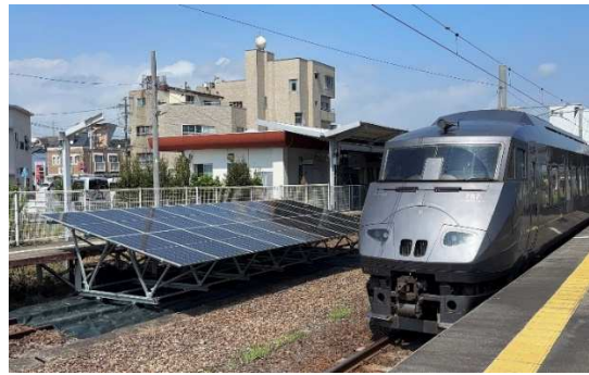
佐土原駅実証状況
