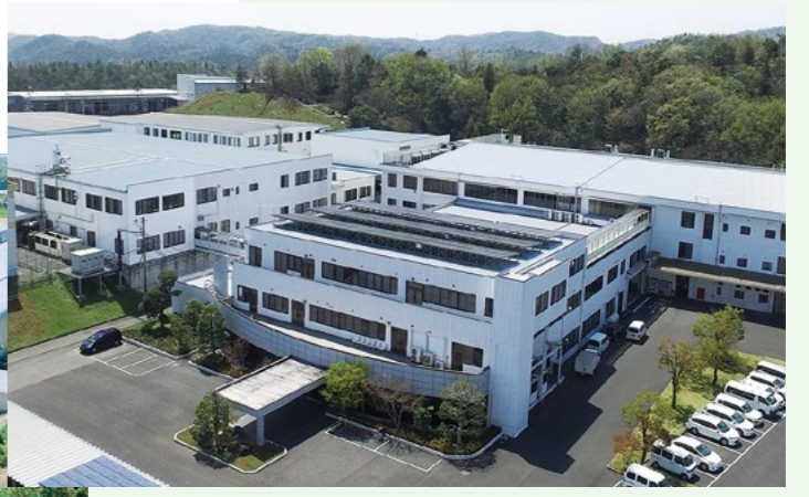
石井表記が2007年に太陽光パネルを設置した工場(上)、太陽光パネルを設置したカッシーナ・イクスシーの伊勢崎工場(下)
