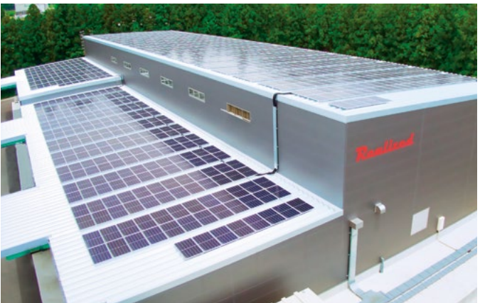
リアライズが新設した多気工場
