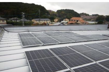
校舎と合宿生用の学校寮の屋根上に約95kWの太陽光発電設備を設置
