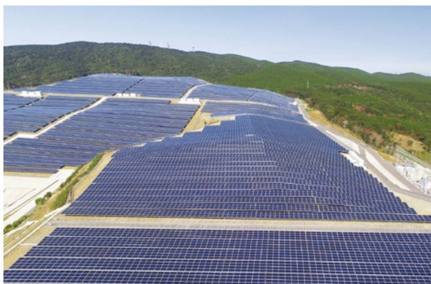
ウエストグループは太陽光発電所を1GW以上建設、管理・保守まで手掛けている
