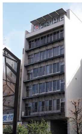
横浜市内のデンソー工業本社ビル
